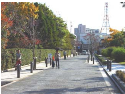
■生活道路における空間づくりの例 (写真：養浩館西側道路)
