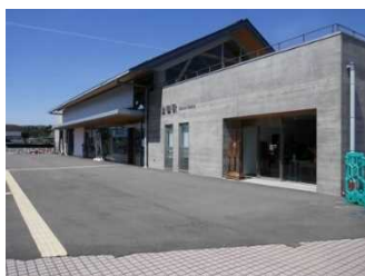
■三国駅の駅舎改修
