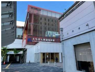
■福井駅の駅舎改修
