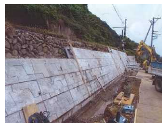
■小舟渡駅付近法面補強
