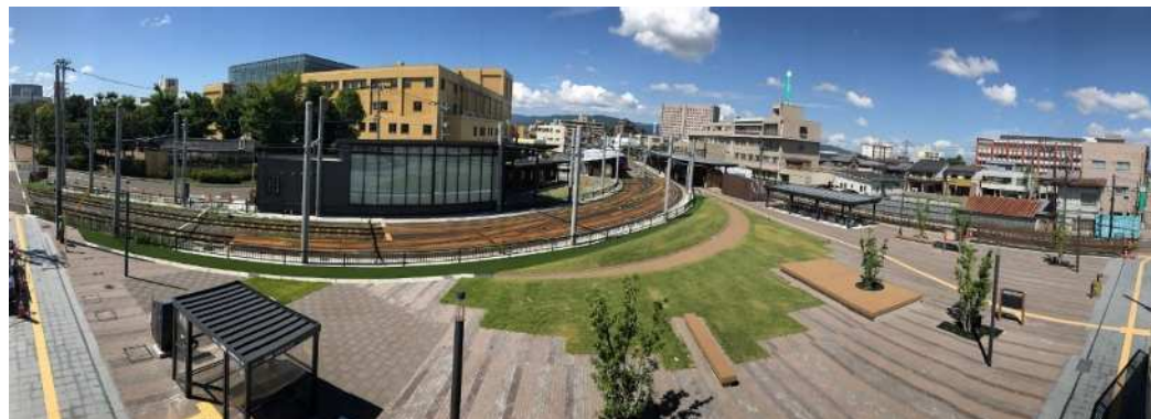
駅舎更新後の田原町駅
