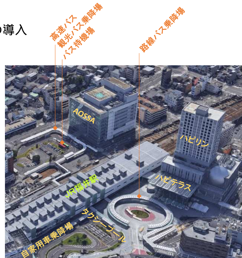
西口広場・東口広場の整備状況 (写真: Google Earth)
